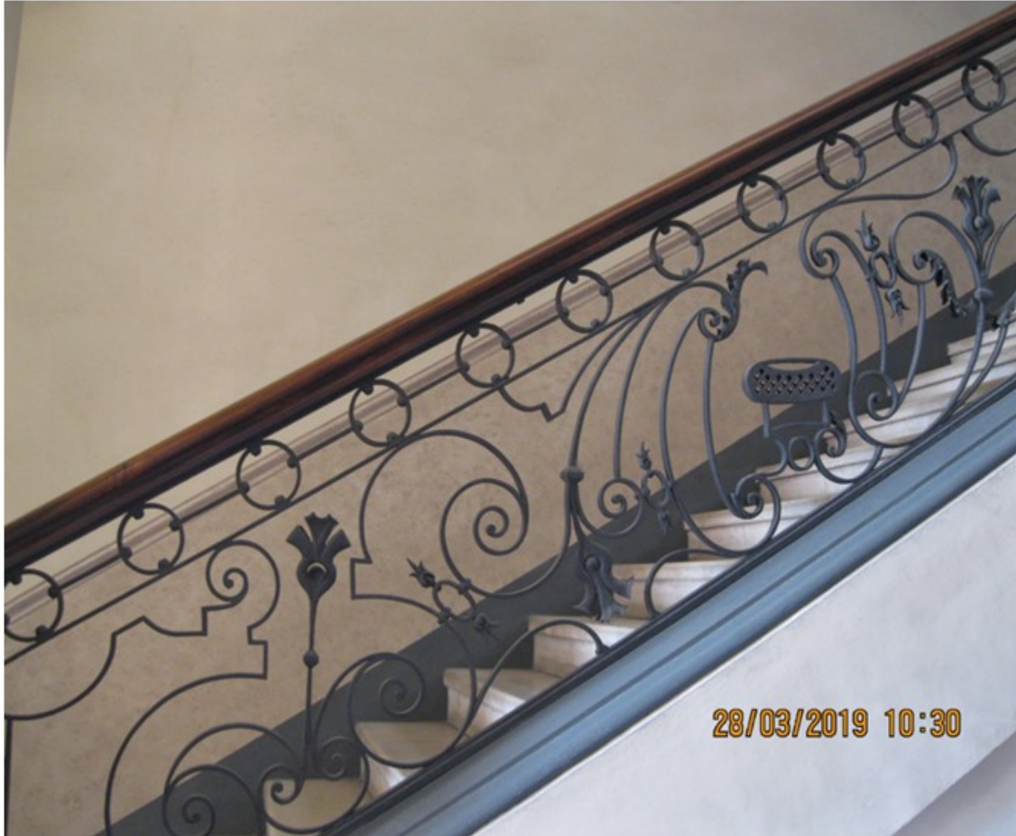
La escalera interior del edificio.
